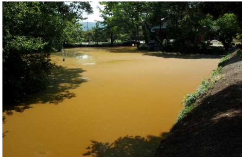
池の汚水400坪 浄化前
